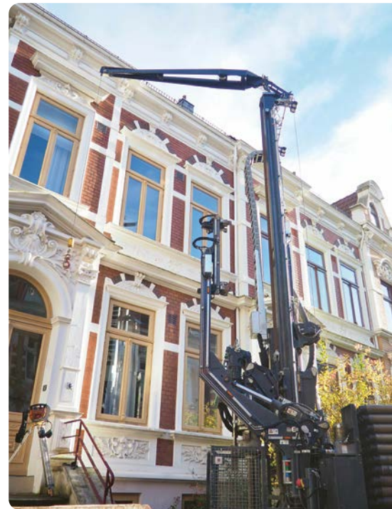
Über eine Erdwärmebohrung ziehen Sole-Wärmepumpen Energie aus dem Boden. Möglich ist das mithilfe einer Sonde, die ein Wasser-Frostschutz-Gemisch (die Sole) tief in das Erdreich schickt.
