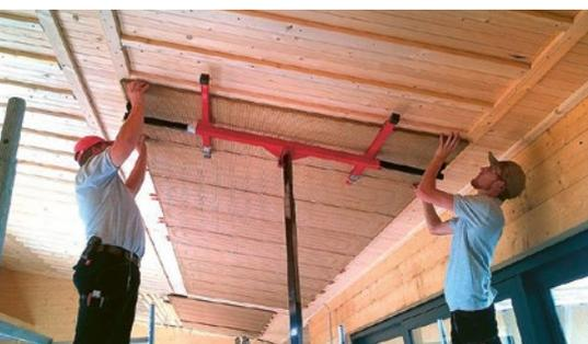
Deckenheizungen aus Lehm stellen eine bauphysikalisch sichere und raumklimatisch aktive Alternative zu konventionellen Systemen dar. Insbesondere bei höheren Räumen eignet sich die Deckenheizung mit einem hohen Strahlungsanteil von 90 Prozent als Heizvariante.
