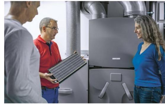
↑ Eine Lüftungsanlage mit Wärmerückgewinnung ist neben der CO<sub>2</sub>-Einsparung auch eine durchaus wirtschaftliche Baumaßnahme, denn sie kann die Heizkosten um bis zur Hälfte senken und schützt das Gebäude vor Feuchtschäden durch fehlerhaftes Lüften.
