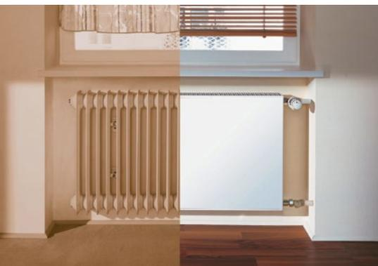
Herausforderungen gibt es manchmal bei der Nachrüstung einer umweltfreundlichen Wärmepumpe: Alte Heizkörper sind oft nicht effizient genug für die niedrigen Vorlauftemperaturen, die Wärmepumpen zur Verfügung stellen. Die müssen dann ausgetauscht werden und sind in dem Zusammenhang sogar förderfähig.
