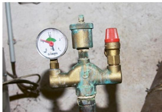
Der korrekte Wasserdruck ist ein wichtiger Faktor für die Funktion einer Warmwasserheizung. Über das Jahr kommt es aus verschiedenen Gründen immer wieder zu kleinen oder auch größeren Verlusten von Heizungswasser.
